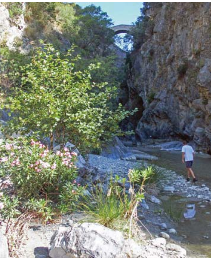
A lato: il Torrente Raganello e, in alto, il Ponte del Diavolo.
