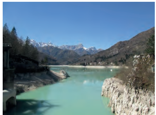
Il serbatoio di Barcis con l'acqua a un livello che mette in luce rocce e sedimenti di solito sommersi.
