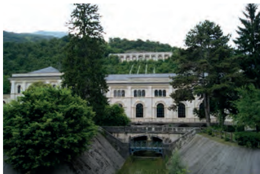
La centrale idroelettrica di Malnisio.
