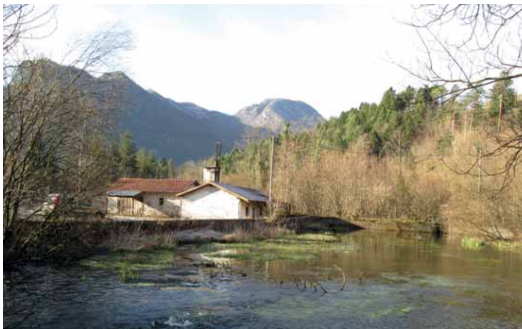
Tramonti di Sopra. Il luogo dell'antico molino e della prima centrale idroelettrica della valle alimentati dalle acque del Vièllia.
